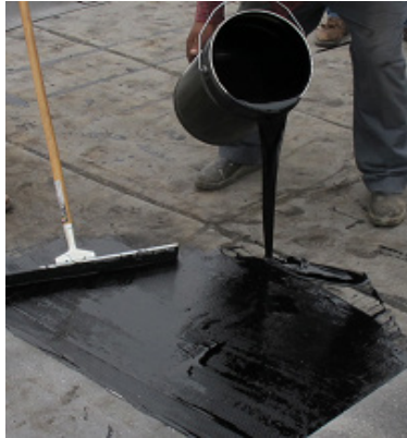
Pour Adhesive on to the substrate
